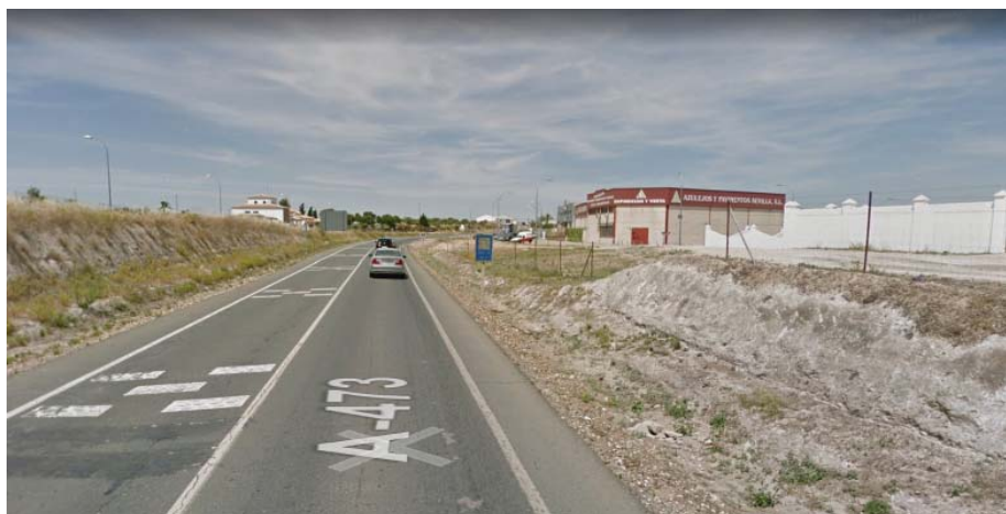
Vista de la carretera y el talud existente en la parcela con el PI al fondo
