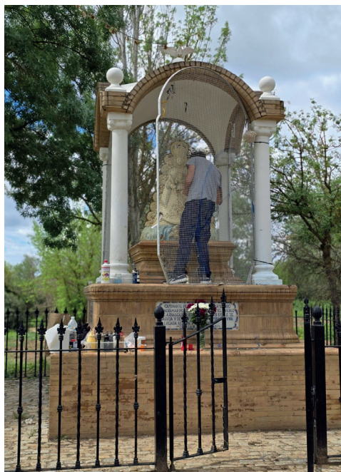
▲ Finalizados los trabajos de retirada de pintura y prevención en la imagen de la Virgen del Rocío del Templete del Vado de Quema, tras el acto vandálico que sufrió meses atrás.
