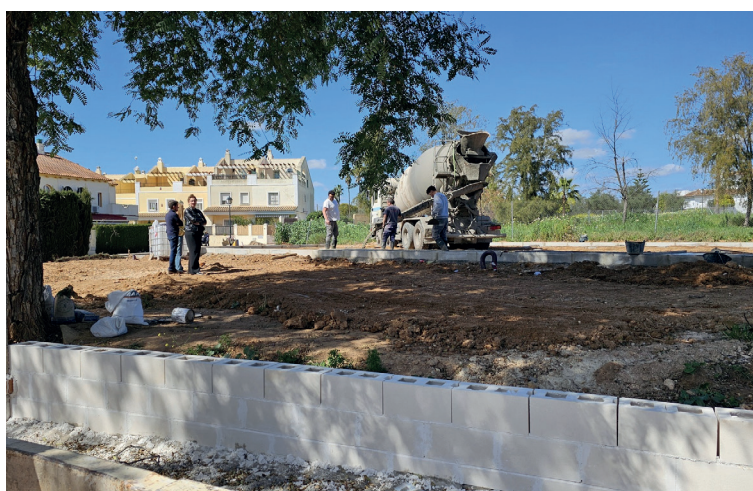
◀ Iniciadas las obras para la creación de un parque y zona infantil en la urbanización Las Minas. Este proyecto se realiza a través del Plan Actúa de Diputación de Sevilla.
