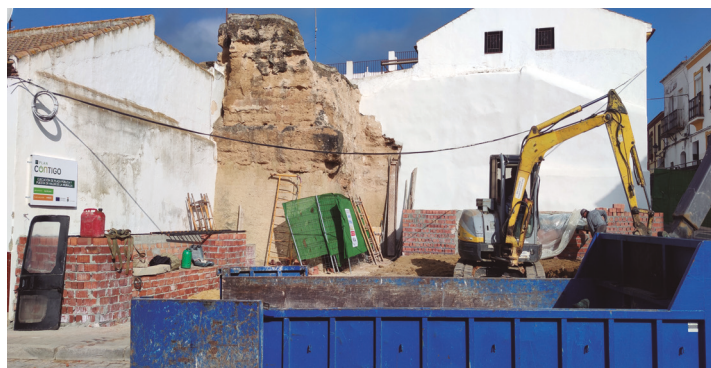
Comienza la obra para la recuperación y puesta en valor de la plaza en la que está visible el paño de muralla, realizada a través del Plan Contigo con un presupuesto de 71.386,79€
